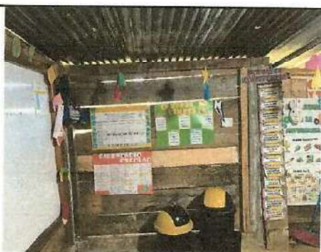
Foto 5: MODULO DE AULAS - Las paredes de madera dejan pasar el agua con las lluvias
